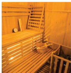
Luminaire sous banquette
